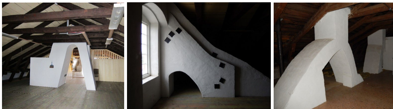
Bilden visar murstockarna på cellängans vind. Murstockarna ingick i det för den tiden nyskapande uppvärmningssystemet utformat med varmluftskanaler. (Bild från platsbesök 2013)
