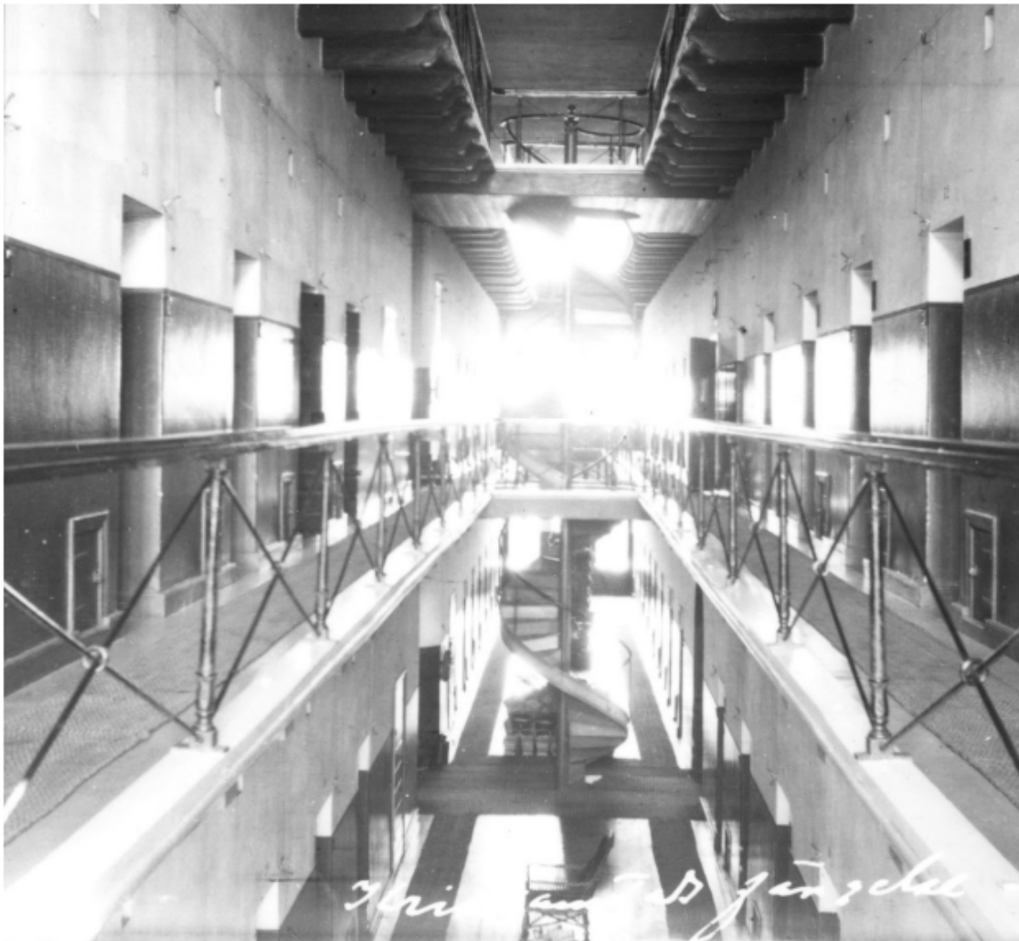
Interiör från cellängan 1905. Mellan våningsplanen fanns ett öppet ljusschakt för att underlätta övervakning. Längan fick naturligt ljus från fönstren i gavlarna och lystes i övrigt upp av fotogenlampor. Observera de små luckorna på sidan om celldörrarna, där nattkärlen kunde placeras så att dörrarna inte behövde öppnas. Ljusschakten byggdes igen under 1950-talet. Bild ur Regionsmuseet Skånes arkiv. Källa: Kulturhistorisk värdering, Fängelset 2, Regionmuseet Skåne, 2022-04-05
