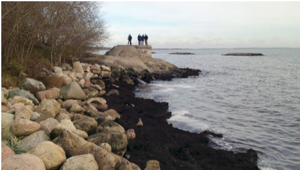
Exempel på strandskoning i form av block eller sprängsten. Bild SGI
