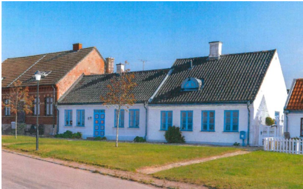
Figur 1. Foto på de två byggnaderna som finns på Malen 2.
