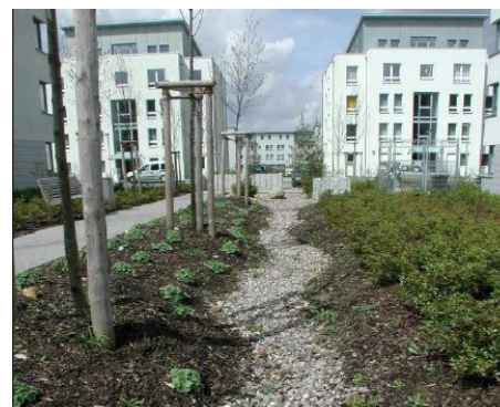
Exempelbild på fyllt dike, Norconsult
