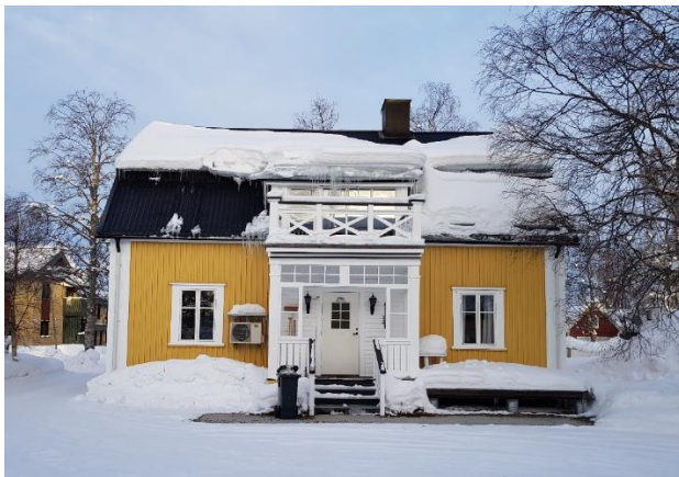
Huvudbyggnad på fastigheten Trasten 13.
