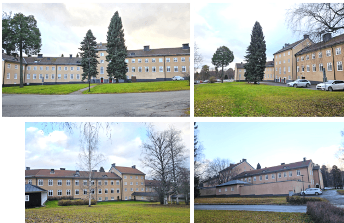
Figur 7: Bilder från planområdet tagna på fram- och baksida av befintlig institutionsbyggnad.
