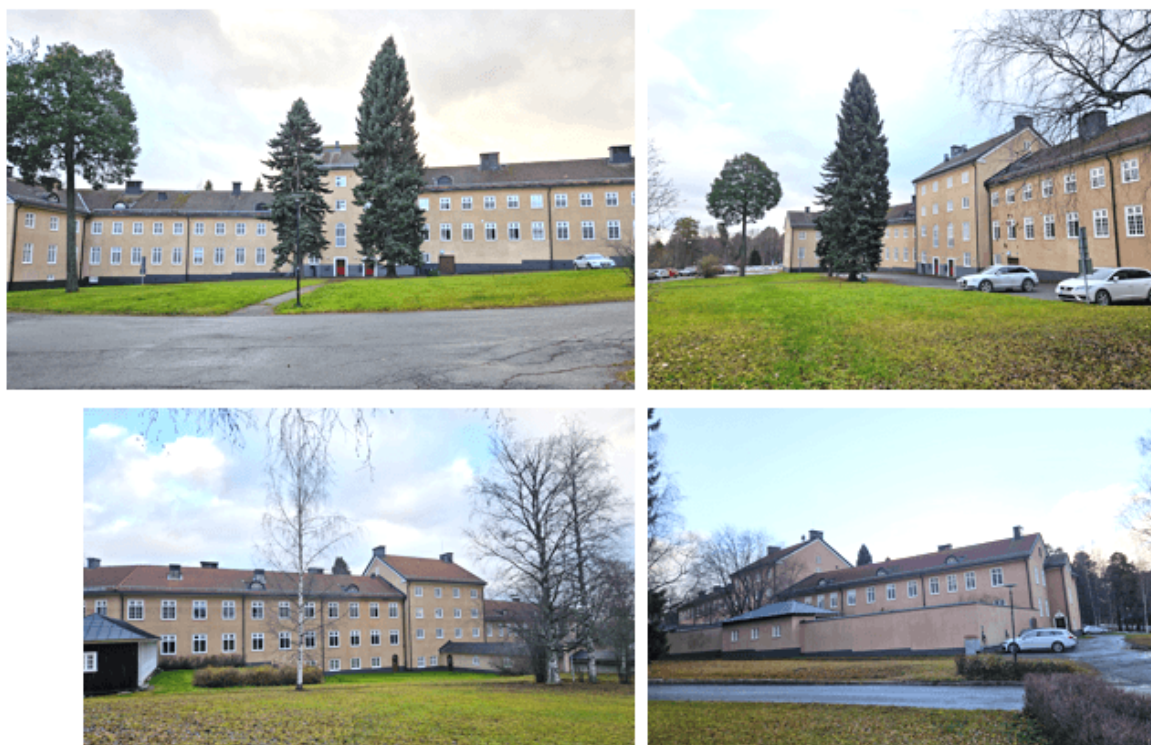
Figur 46: Bilder från planområdet tagna på fram- och baksida av befintlig institutionsbyggnad.
