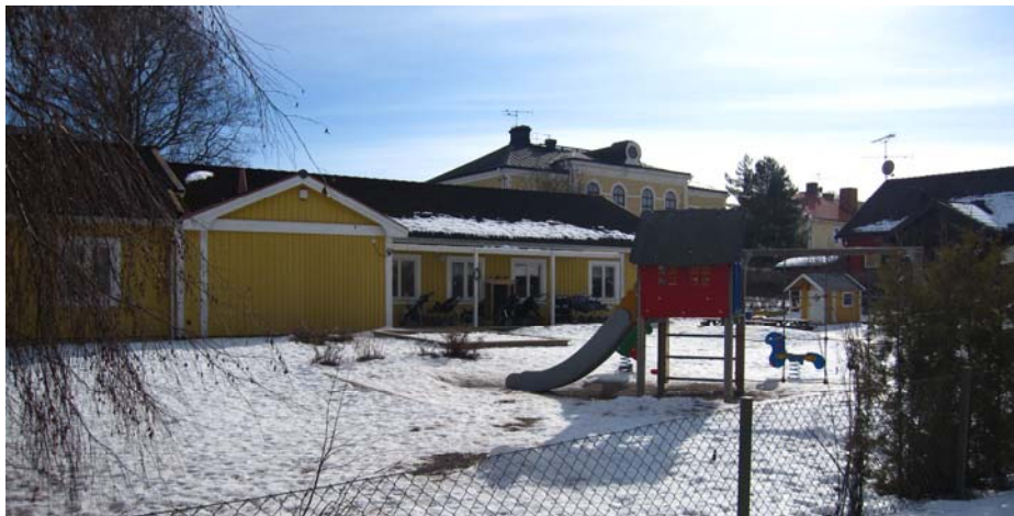
Rymningen 8:99, sett från Idrottsvägen
