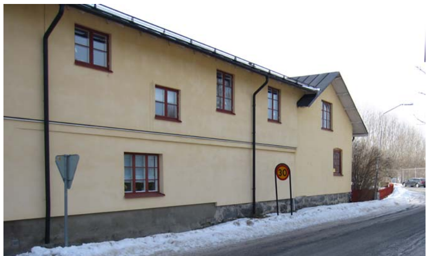
Rymningen 1:3 sett från Idrottsvägen
