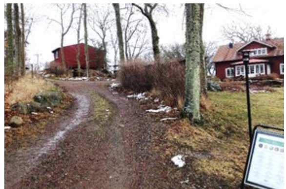
Bild 20. Uppfart till Spa-byggnaden, bostadshus till höger.
