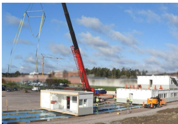
Figur 18: Gärdesta modulsola monteras på slipers maj 2022 (bild: Fastighetsenheten Sala kn).
