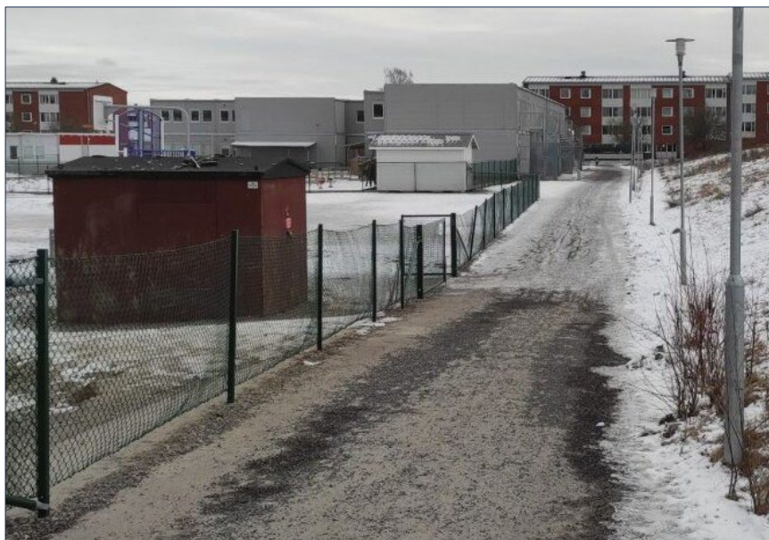
Figur 37: Transformatorstation och belysning. Bild tagen från väster. Ekdalens modulförskola och Åkraområdet i bakgrunden. Vallen till höger.
