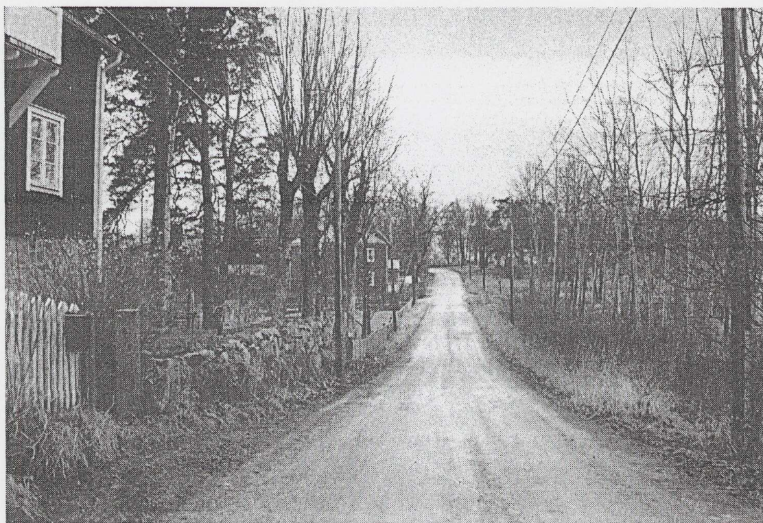
Kyrkvägen från nordost. Till höger i bild syns det område som avses bli begravningsplats i en första etapp.
