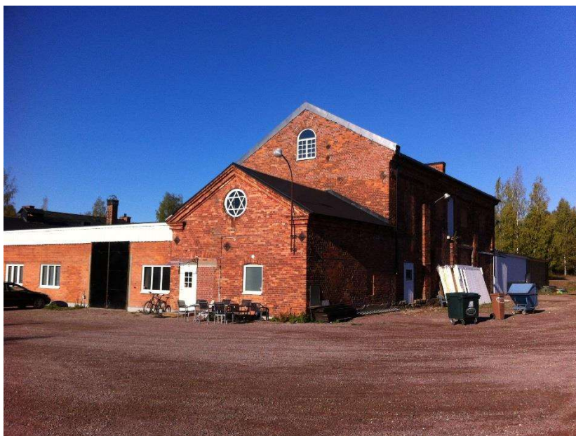
Bilden visar den östra industribyggnaden som i detaljplanen får varsamhetsbestämmelser sett från söder.
