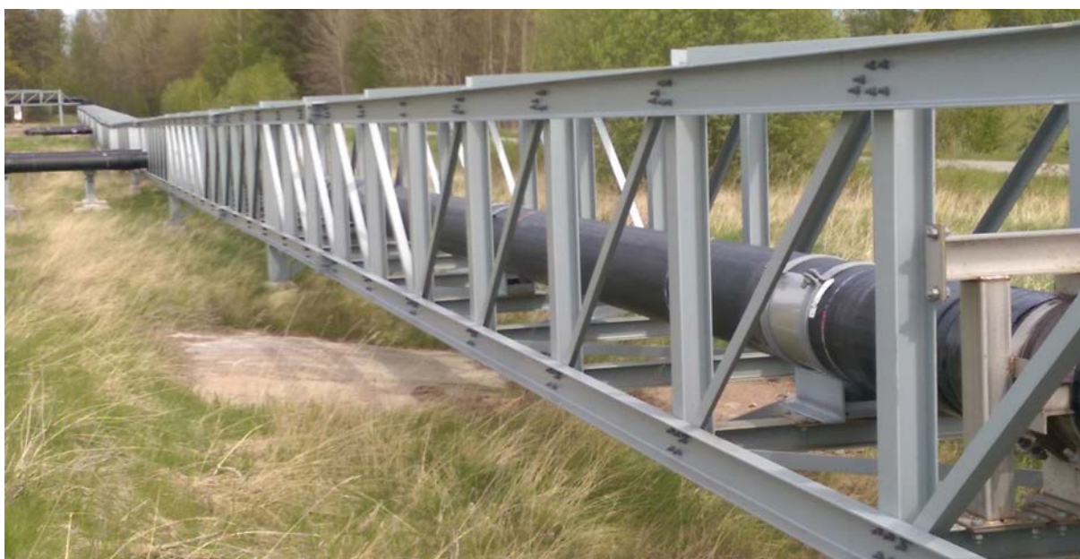
Nedan - Befintlig ångledning i rörbryggestruktur söder om Västerbyverket.
