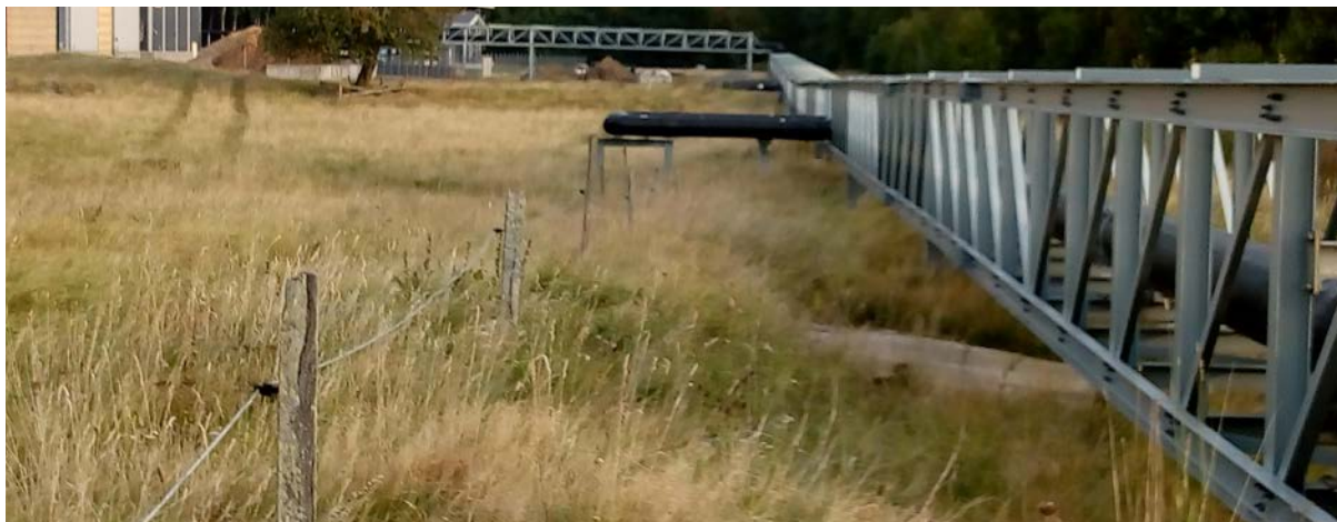
Den befintliga rörbryggedelen som ansluter värmeverket i norr. Svarta rördelar som vinklar ut åt vänster är de sk lyrorna. Lokalt behöver även lyrorna skyddas från påkörning av interntrafiken på industriområdet med stålbrygga liknande övrigt.
