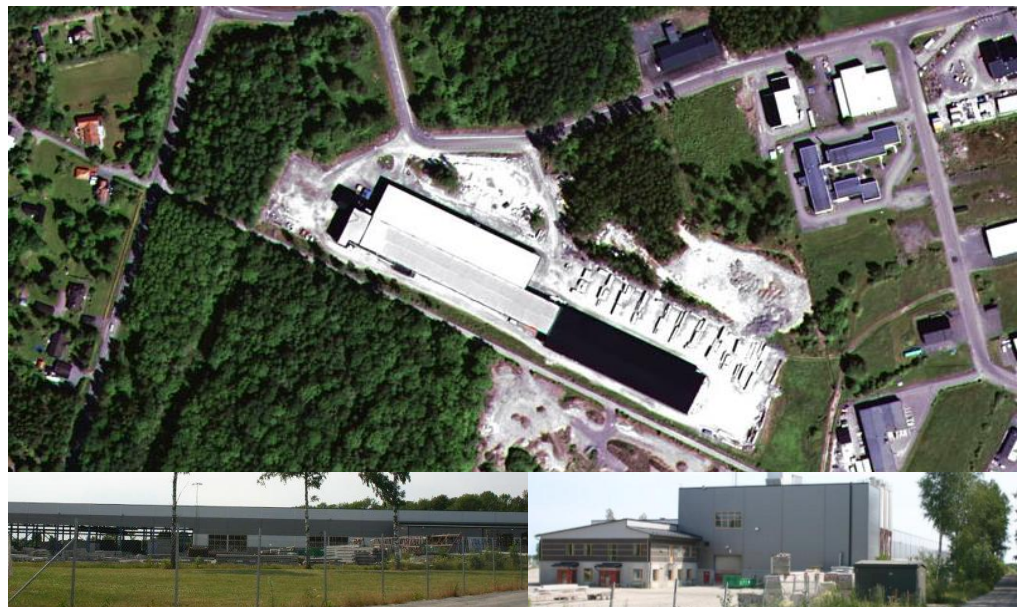
Ortofoto över aktuellt planområde från 2007 samt bilder på befintlig byggnad
