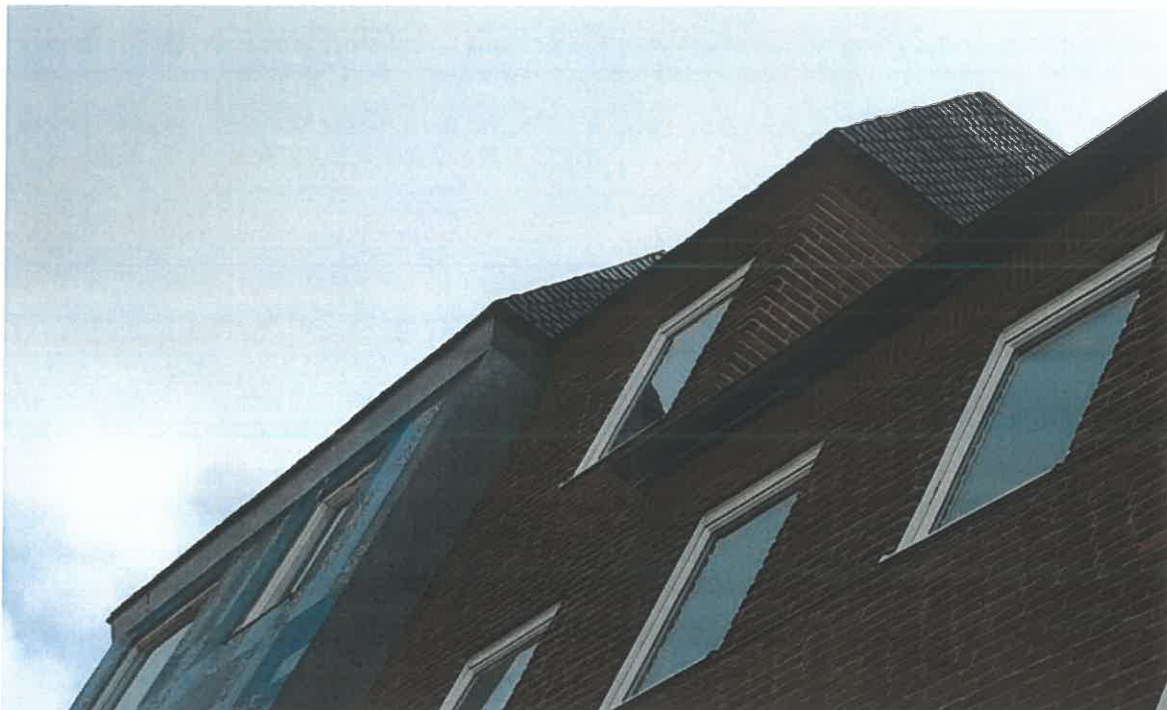
Figur 11. Skiffertaket med dess takfot. Observera också den nätta takfoten på den lägre delen med plåttak.
