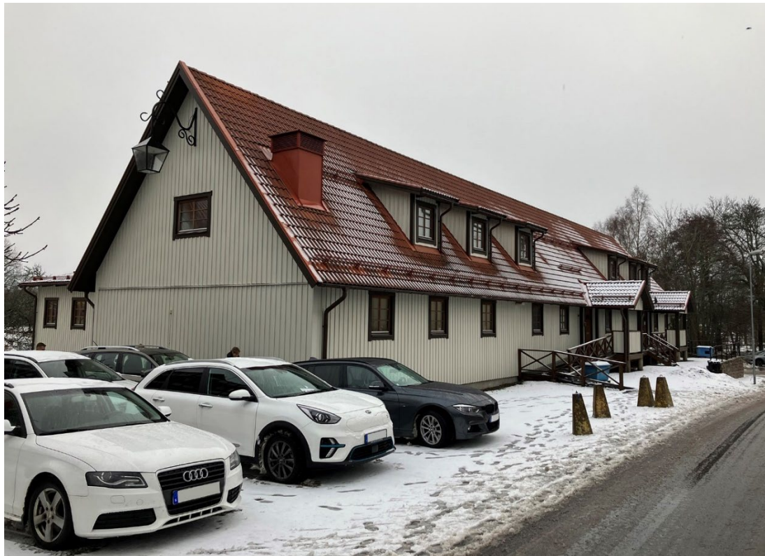
Kontorsbyggnaden sett från norr. Hyttgatan till höger.
