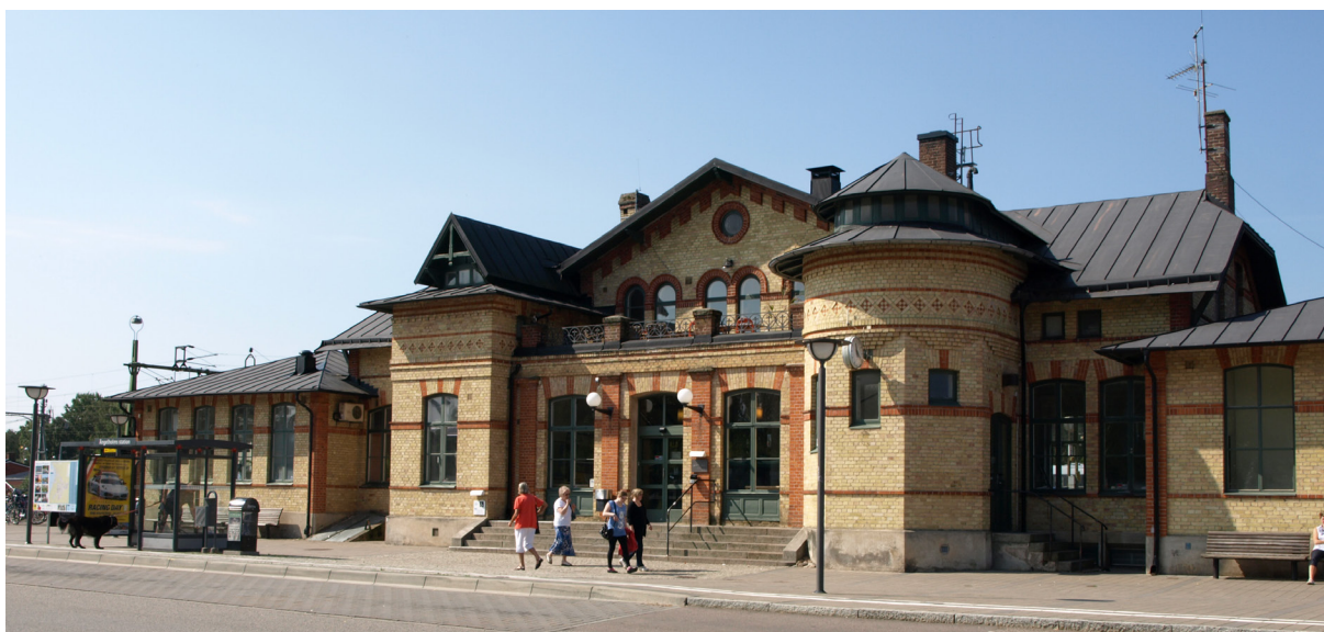
Stationshuset bedöms ha ett kulturbistoriskt intresse.
