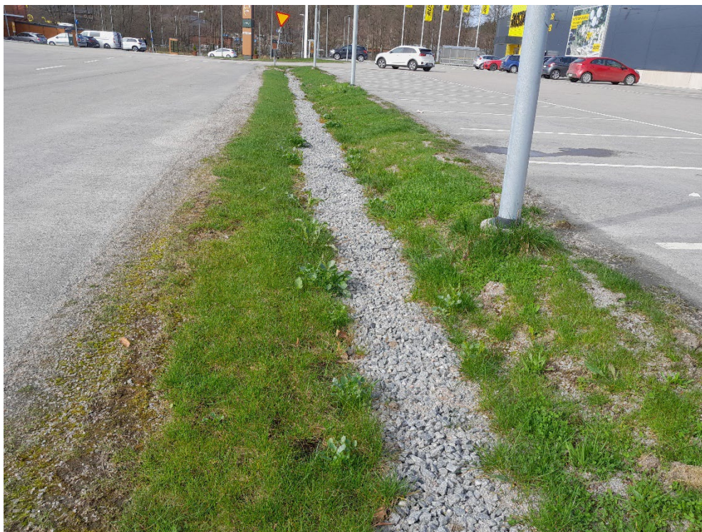
Fotografi av makadamfylldt dike i anslutning till parkeringsyta. Fotografiet är taget mot väster med Gripenvägen på vänster sida i bild.
