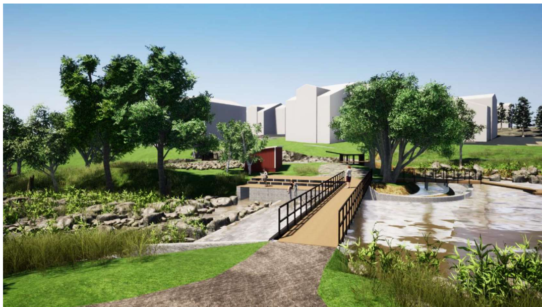
Figur 33. Visualisering av Slussholmen efter byte av dämme och fiskvandringssvåg. Vy över dämmet från östra stranden. Notera att fiskvandringssvågen är flyttat till Slussholmen och att övergången över dämmet är bredare. Norr om Slussholmen kan det övre inläppet till fiskvandringssvågen ses tillsammans med den nya bryggan. (Österåkers kommun visualiseringsenheten)
