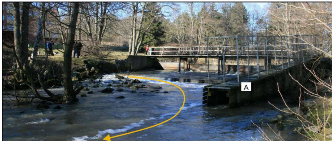
Figur 23. Befintligt dämme med nuvarande fiskväg (A). Fotografi upp mot dämmet från kanalens östra strand i riktning mot Slusssholmen. Den dominerande strömfåran markerad med gul pil.
