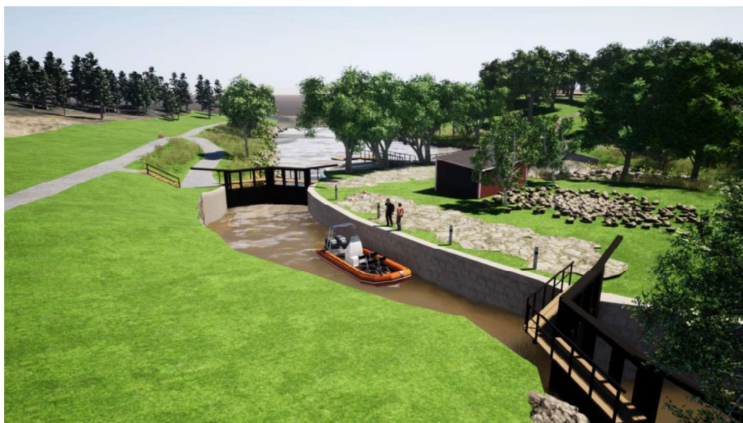
Figur 20. Visualisering av Slussholmen efter renovering av slussanläggningen. Vy från västra stranden över slussanläggningen. Notera den nya öppningsanordningen på slussportarna och rampen upp till cykel- och gångvägen på västra stranden. Norr om Slussholmen kan den nya bryggan över fiskvandringvägen skimras. (Österåkers kommun visualiseringsenheten)
