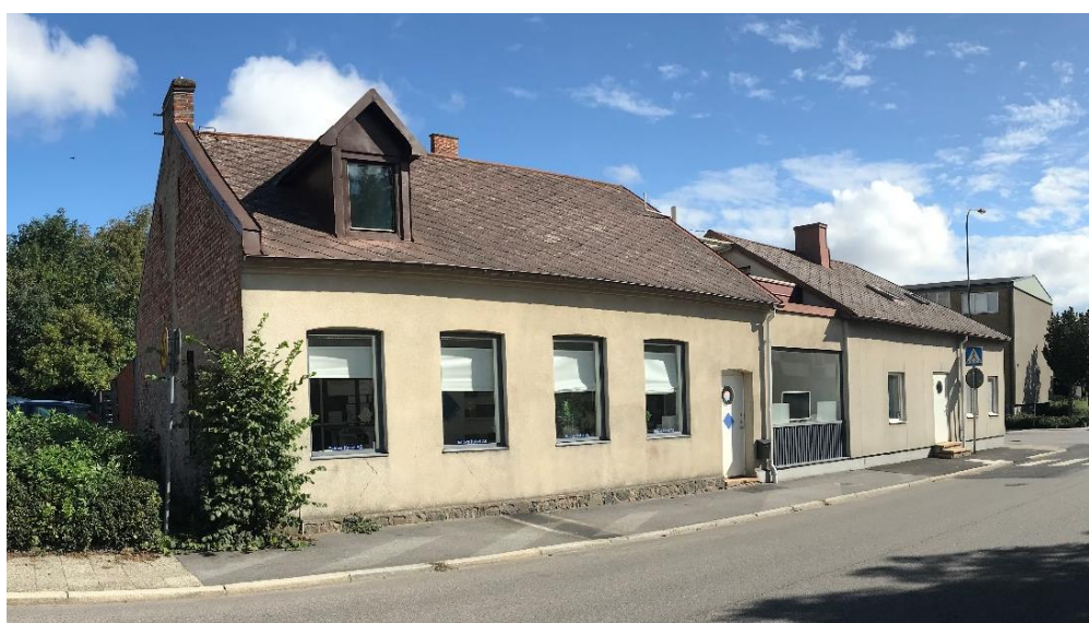
Befintlig bebyggelse inom planområdet sett från Repslagaregatan
