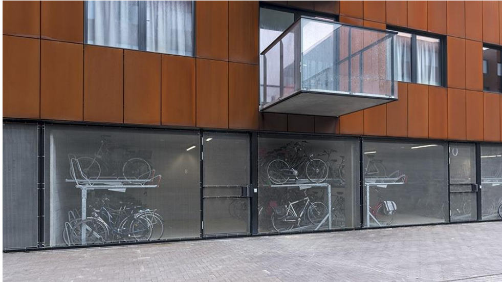
Exempel på cykelparkering i bottenvåning av ett bostadshus
