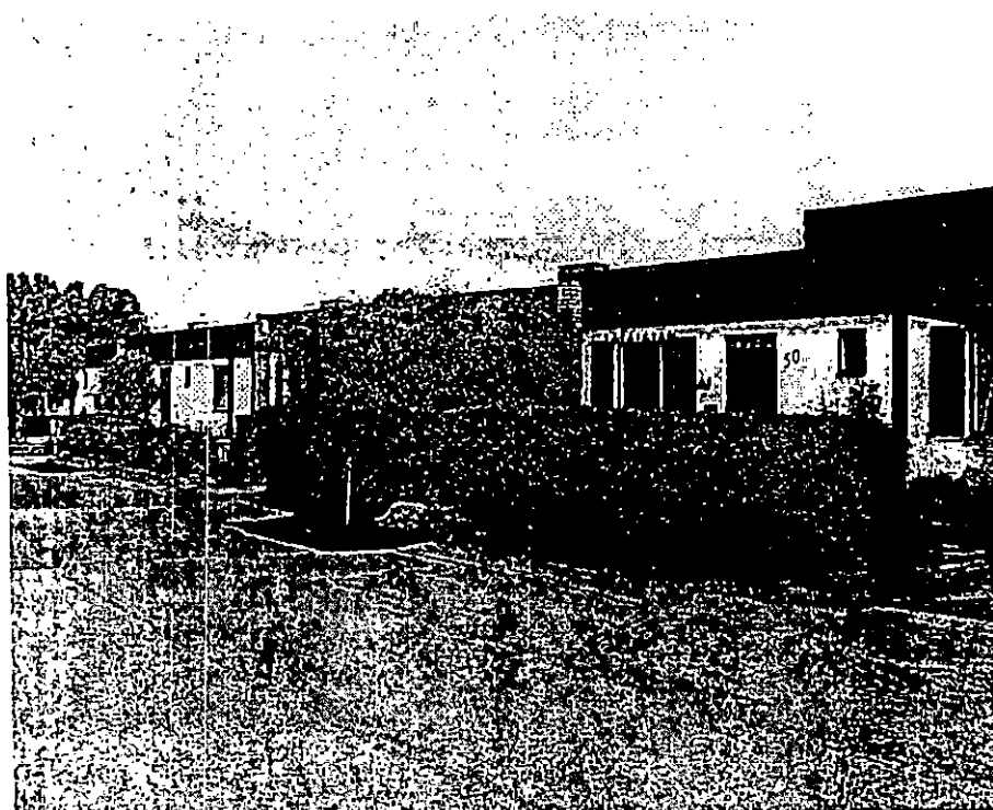
Fig.5; En plans kedjehus utmed Ringvägen.
