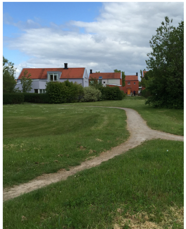
Nedsänkt gräsyta som kan fungera som fördröjningsmagasin vid regn. Mariastaden, Helsingborg.
