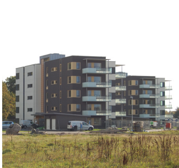
Bild på flerbostadshusen i Albinsro. De högre flerbostadshusen är uppförda i femvåningar. Visuellt stöd ges av vegetationen på Trottaberg.
