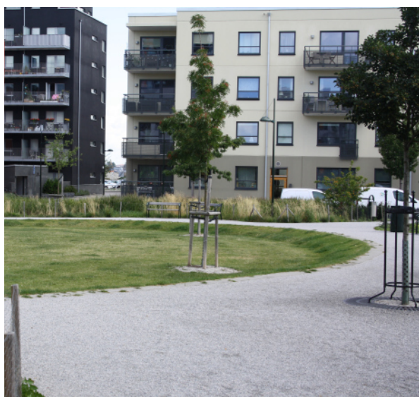
Exempel på en park med en något nedsänkt gräsyta som även kan användas för fördröjning av dagvatten..
