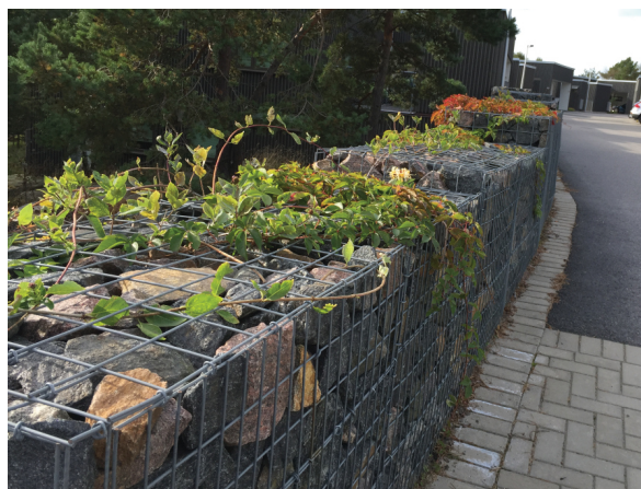
Bild som visar hur en sk gabion ser ut - ett nät som fyllts med stenkross och som ofta används för att ta upp höjdskillnader längs vägar, som avgränsning istället för mur eller häck etc.
