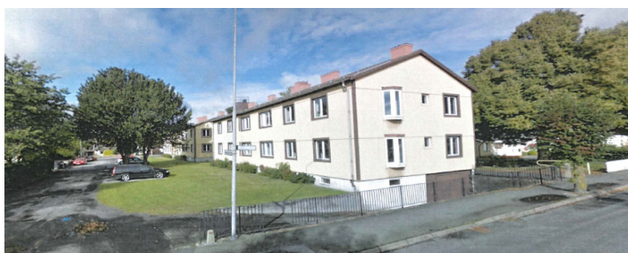
Befintlig tomt som den ser ut idag samt en bild med tidigare bebyggelse.
