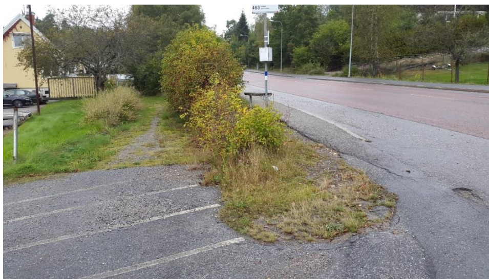
Figur 19. Dike saknas mellan väg 274 och befintlig bebyggelse. Vägområdet är mycket otydligt, men har tolkats in vid släntfot. Vy ifrån öster.
