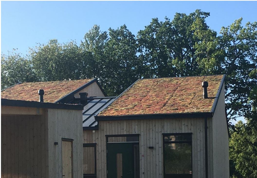
Figur 4 Grön tak med sedumväxter
