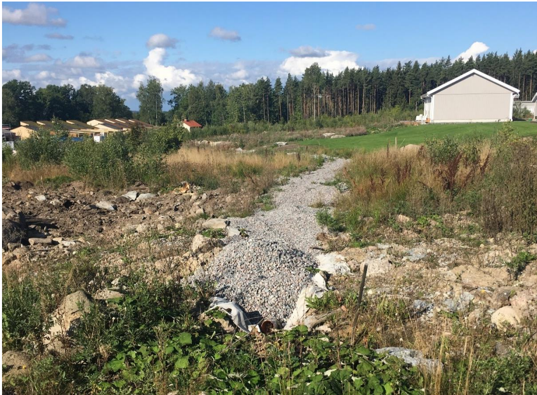
Figur 5 Dräneringsdike med singel och dräneringsrör
