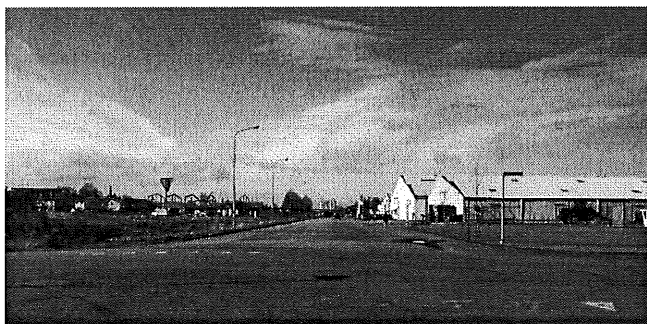
Befintlig gatussektion (Sockerbruksgatan)
