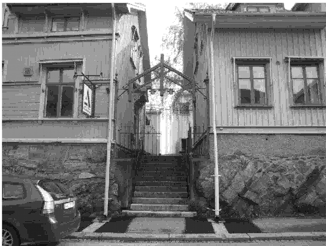
Trappa mellan fastighetens båda byggnader
