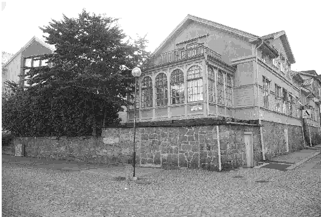
Västra byggnaden mot Strandgatan och kanalen
