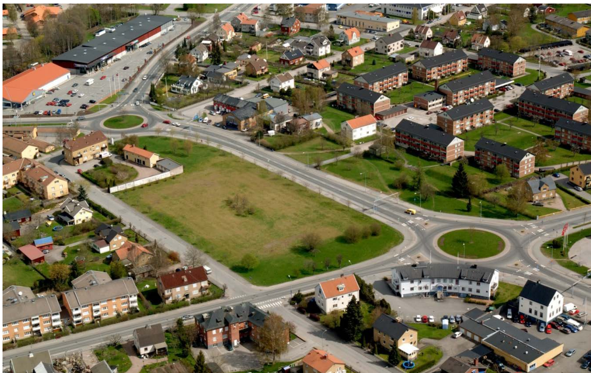
Befintliga byggnader inom kvarteret Städet. Samtliga byggnader inom kvarteret ska rivas.
