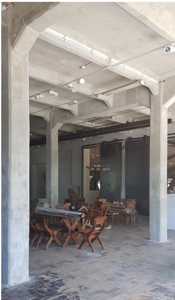
Den vänstra bilden visar konstruktionen med pelare och betongdäck. Den högra visar ståltakstolarna i den lägre delen.
