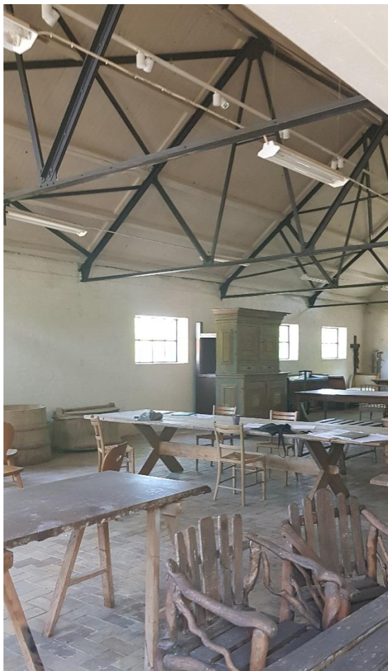
Den vänstra bilden visar konstruktionen med pelare och betongdäck. Den högra visar ståltakstolarna i den lägre delen.
