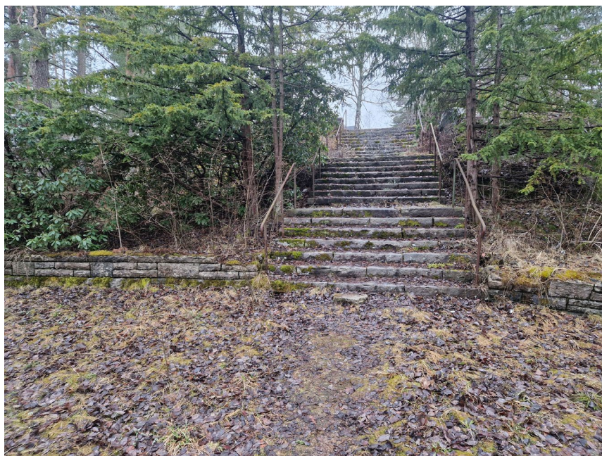
Figur 4: Befintlig stentrappa inom kvartersmarkens östra delar.
