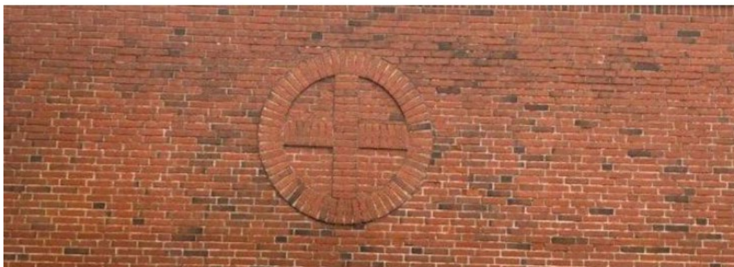
Detalj från tegelfasad med uppvisande av vilt tegelförband och reliefmurat kors.
