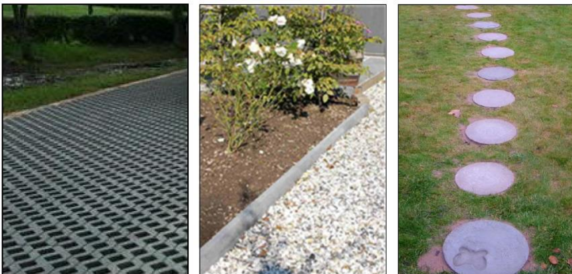
Yta med hålsten av betong, makadambelagd gång, samt gångstig med gräs och några gångplattor i betong (Foto: Norconsult).
