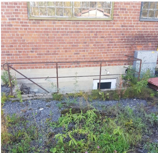
Figur 7. Källartrappa på garagets nordvästra sida. Bild: Daniel Eriksson, Tyréns.
