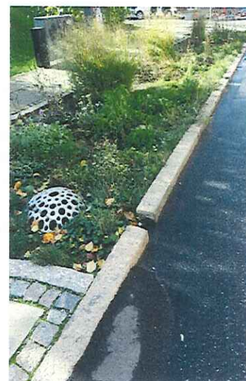
Exempel på raingardenlösning i Köpenhamn.
