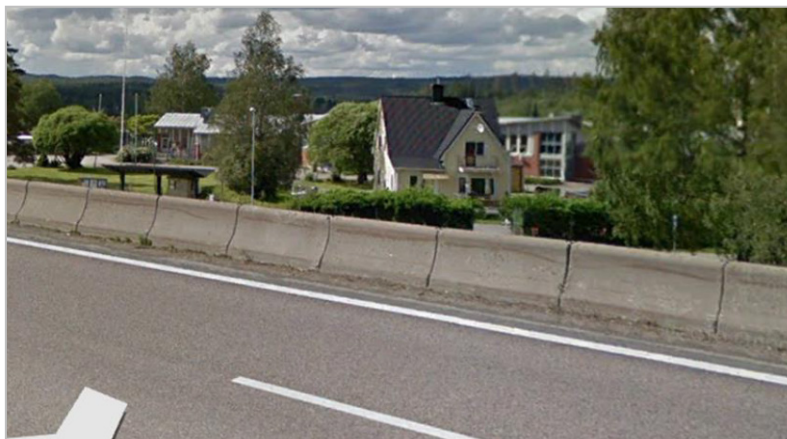
Betongbarriär. Källa: Sweco Systems AB 2021.
