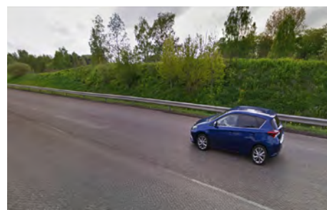
Befintlig skyddsvall mellan Östra leden och den södra delen av planområdet (bild från Google Maps)
