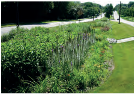
Exempel på växtfyllt svackdike
