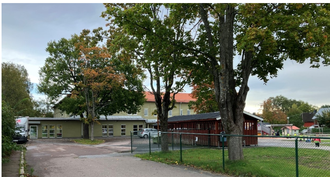
Figur 18. Förskolebyggnaden, Hus 5, sett från Björngränd (väster) med liggande träpanel i grönt och röda takpannor.
