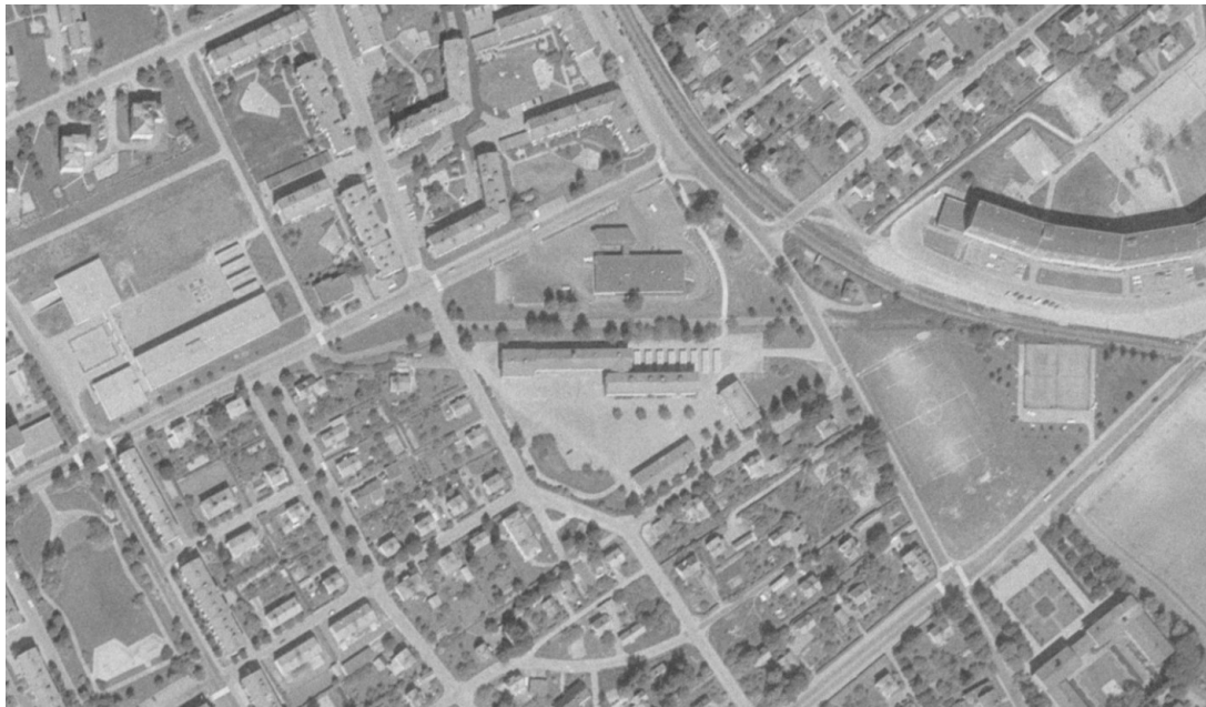
Figur 13. Flygbild från omkring 1975. Maserskolan har byggts ut, väster om Tjärnaskolan. Öster om Tjärnaskolan går Allfarvägen i den äldre sträckningen, ner till stadshuset. På fastigheten Pluto 1 har bensinstationen byggts ut. Källa: Lantmäteriet.
