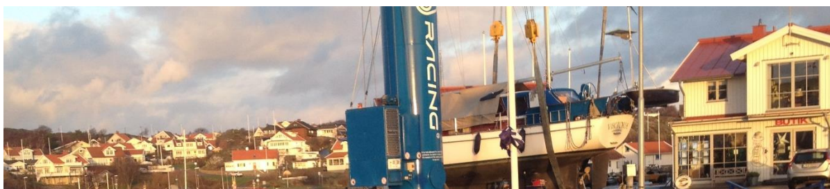
Bild ovan; Omgivande bebyggelse, Teknik- och miljöbod anpassas genom dess vita träfasad och röda plåttak
