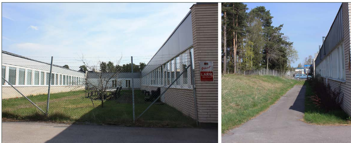
Figur 4: Marken är delvis gräsbeklädd, med inslag av asfaltsytor. En tydligt markerad slänt finns på västra sidan av byggnaden (höger bild).
