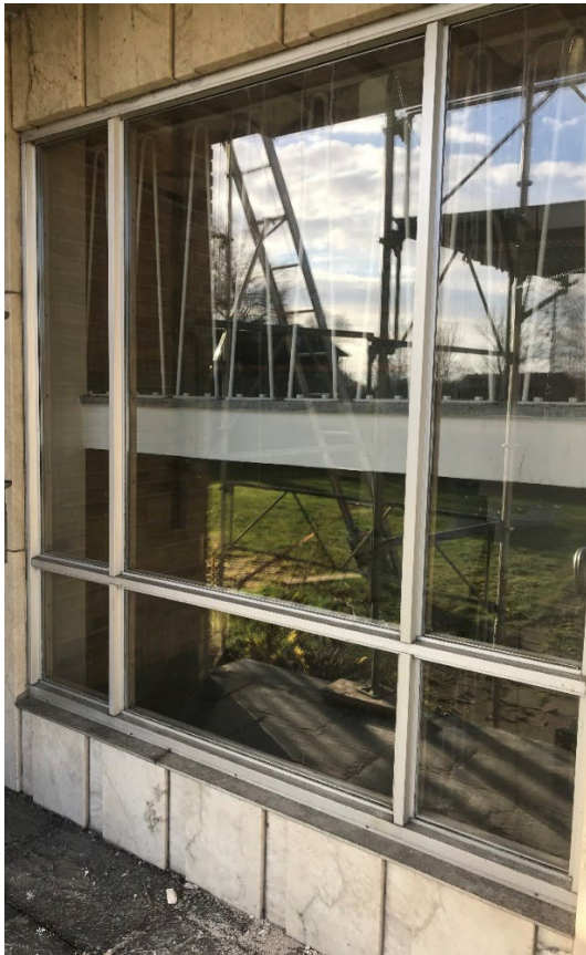
Smäckra fönsterpartier av trä med utvändig beklädnad av aluminium
