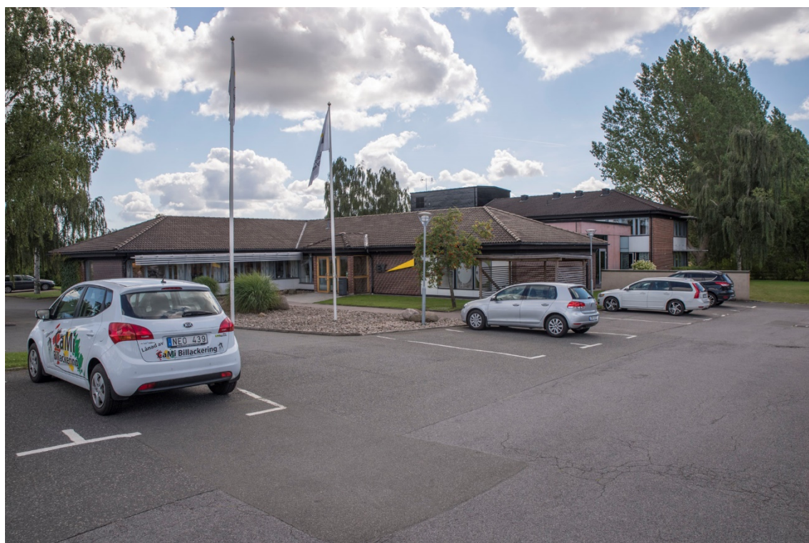
Kontorsbyggnad inom fastigheten Revisorn 31. Foto: Per Blomberg (2017-08-15)
