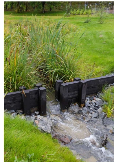
Dagvattendike i Tollare Park, Nacka, foto: Veg Tech
