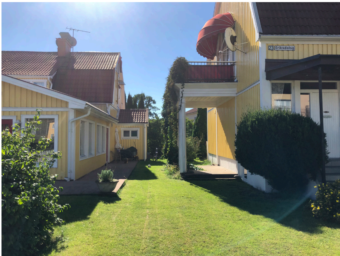
Till vänster i bild är huvudbyggnaden intill Lagmansgatan (med tidigare restauranglokal) och till höger i bild är bostadshuset vid Eriksdalsgatan. Eventuell ny fastighetsgräns föreslås gå två meter utanför fasaden till vänster i bild och en meter från balkongen på huset till höger i bild.
