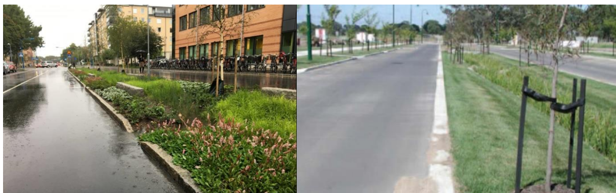
Exempel på dagvattenhantering med biofilter. Källor: till vänster, Boverket.se och till höger Svenskvatten.se.
