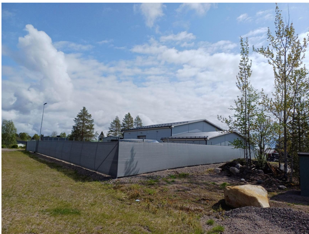
Figur 5. Befintlig byggnad på Arvidsjaur 6:13
