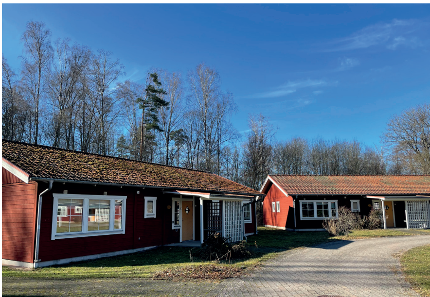
Foto på två av de sju befintliga byggnaderna inom planområdet som tidigare använts som elevbostäder.
