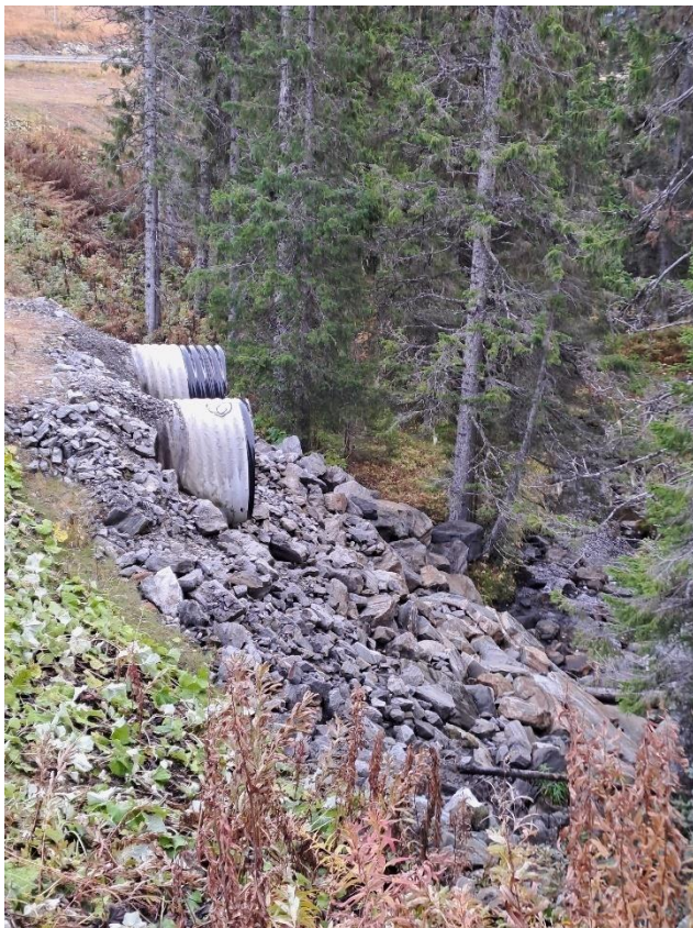
Figur 13. Den erosionsskyddade slänten med kross. Foto: Åre kommun.
