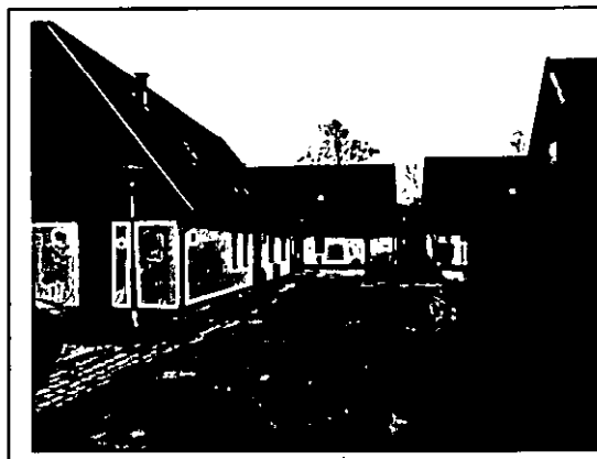
Foto 1: Det norra 70-tals området med grupphus.
