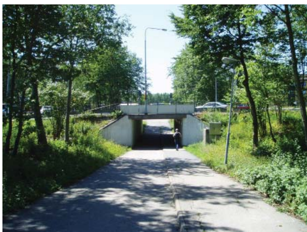
Före gallring var området runt tunneln något vildvuxet.
