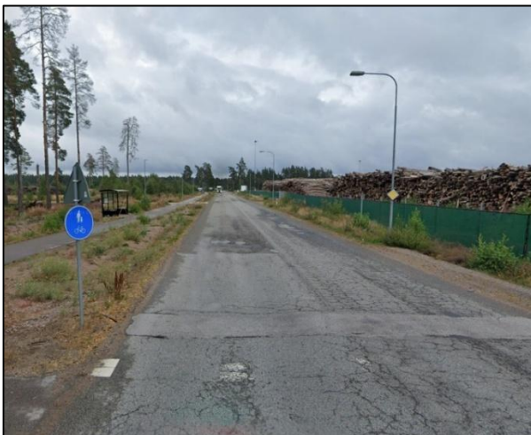
Silverslättsvägen från väster. Busshållplatsen är inte längre i bruk då busslinjen dragits om och inte längre passerar platsen.
