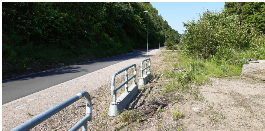
Gång- och cykelväg på banvallen söder om planområdet.
